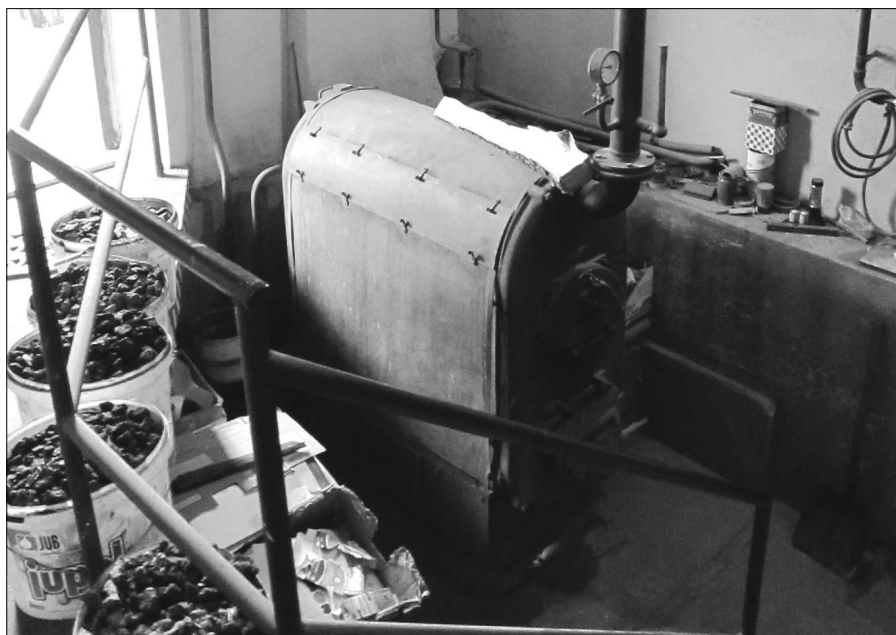
Mateřská škola – stará kotelna
