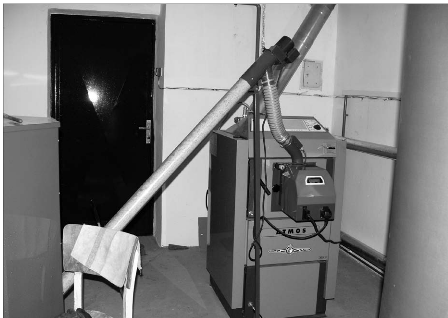
Mateřská škola – nová kotelna
