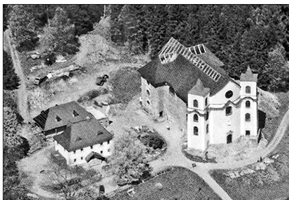
opravený kostel v Neratově
