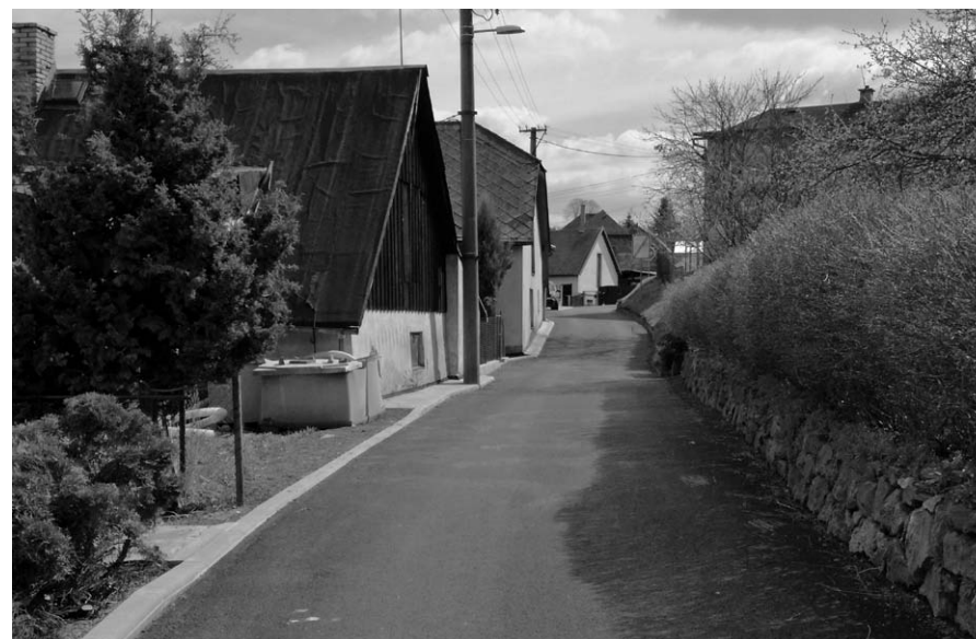
oprava místní komunikace „Ulička“
