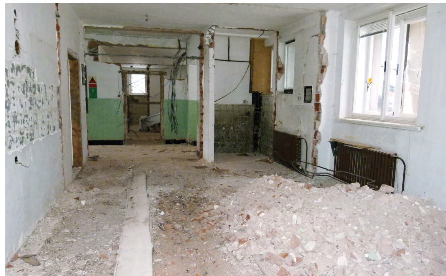
rekonstrukce čp. 116 a 117
