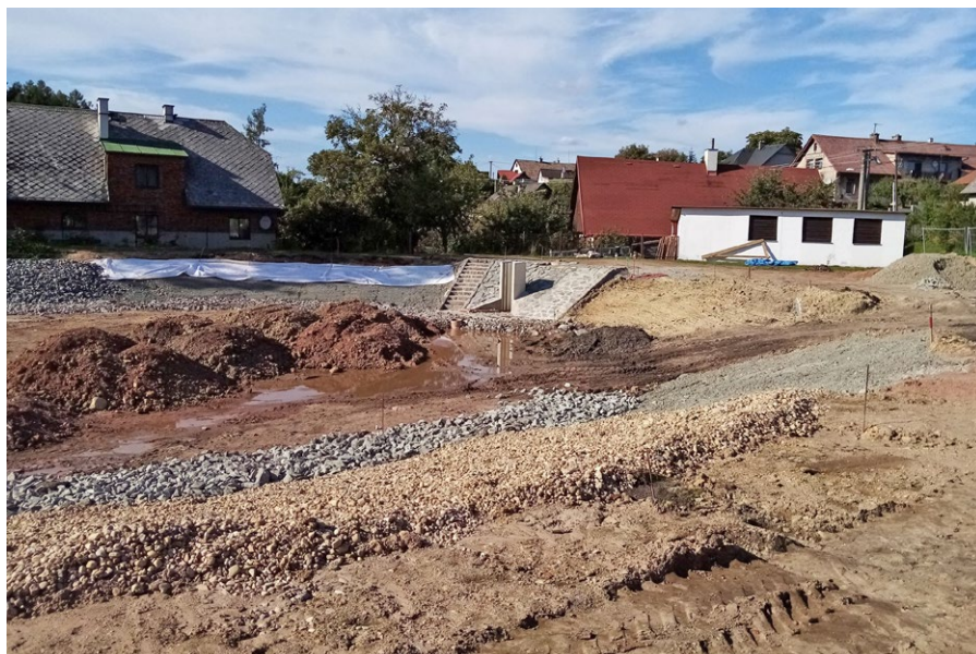
revitalizace obecní nádrže
