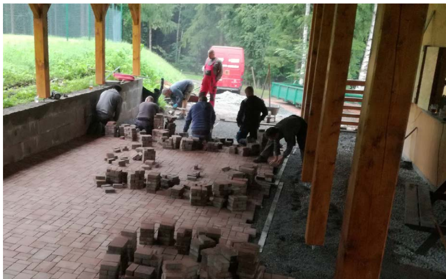
pokládka dlažby na sokolovně
