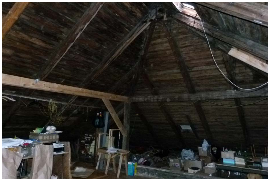
půda před rekonstrukcí
