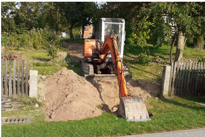
budování nové kanalizace
