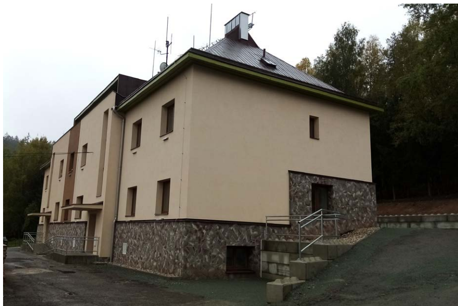
rekonstrukce obecního domu číslo popisné 116 a 117
