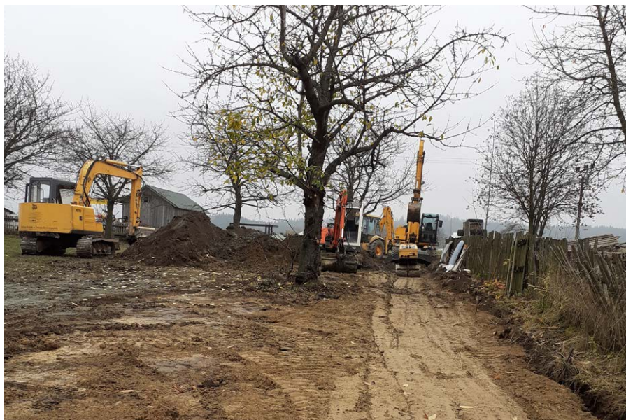
realizace výstavby kanalizace
