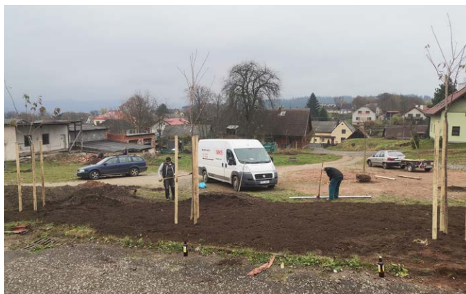
sázení stromků a terénní úpravy
