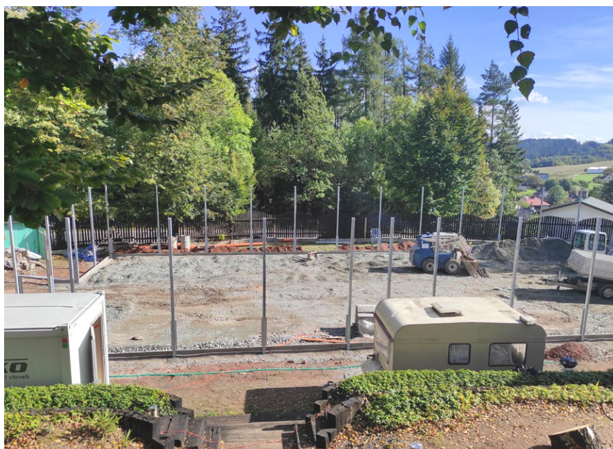
začínající stavba multifunkčního sportovního hřiště
